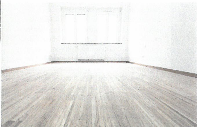
Das Eiche-Mehrschichtparkett wurde mit einem sehr emissionsarmen und lösemittelfreien 1-K Klebstoff verklebt
