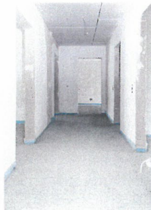
Im gesamten Wohnungsbereich entsteht ein einheitlich ebener Boden
