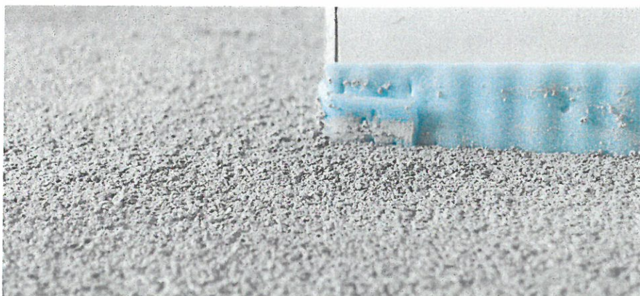
Bodensanierung schnell und unkompliziert ausgeführt: Das eingesetzte System ermöglicht einen großflächigen Niveau-Ausgleich, Wärme- und Trittschalldämmung inklusive
